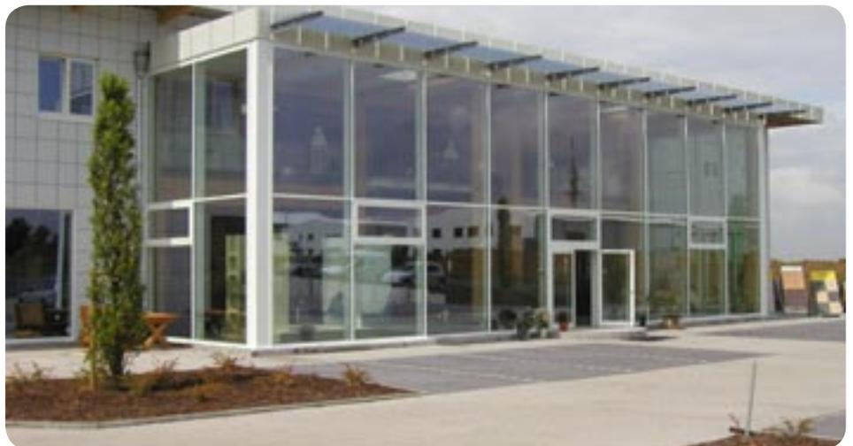
Glasfassade des Ausstellungszentrums von Fliesen Büngeler in Büren: Pilkington Activ™-Außenscheiben wurden hier mit Verbund-Sicherheitsglas kombiniert und in eine schmal profilierte Aluminium-Konstruktion montiert.
