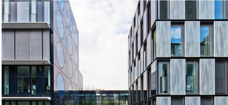
Abgestimmt auf Himmelsrichtung und Innenraum sind in den Sekundärfassaden des B.O.C. schwarze „Photovoltaiktafeln“ und weiß bedruckte „Klimascheiben“ eingesetzt worden. Diese sorgen nicht nur für einen geringeren Wärmeeintrag, sondern erzeugen im Inneren auch angenehme, changierende Lichtstimmungen. Der hell-dunkel Kontrast der Gläser im Wechsel von weißer Klima-, grauer Isolier- oder schwarzer Photovoltaiktafel verleiht dem Haus eine zeichnerhafte Wirkung.
